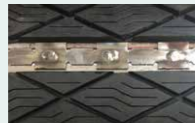
Nahaufnahme: auf die Oberfläche der Antriebstrommel aufgeschweißter Slide-Lag-Reibbelag
