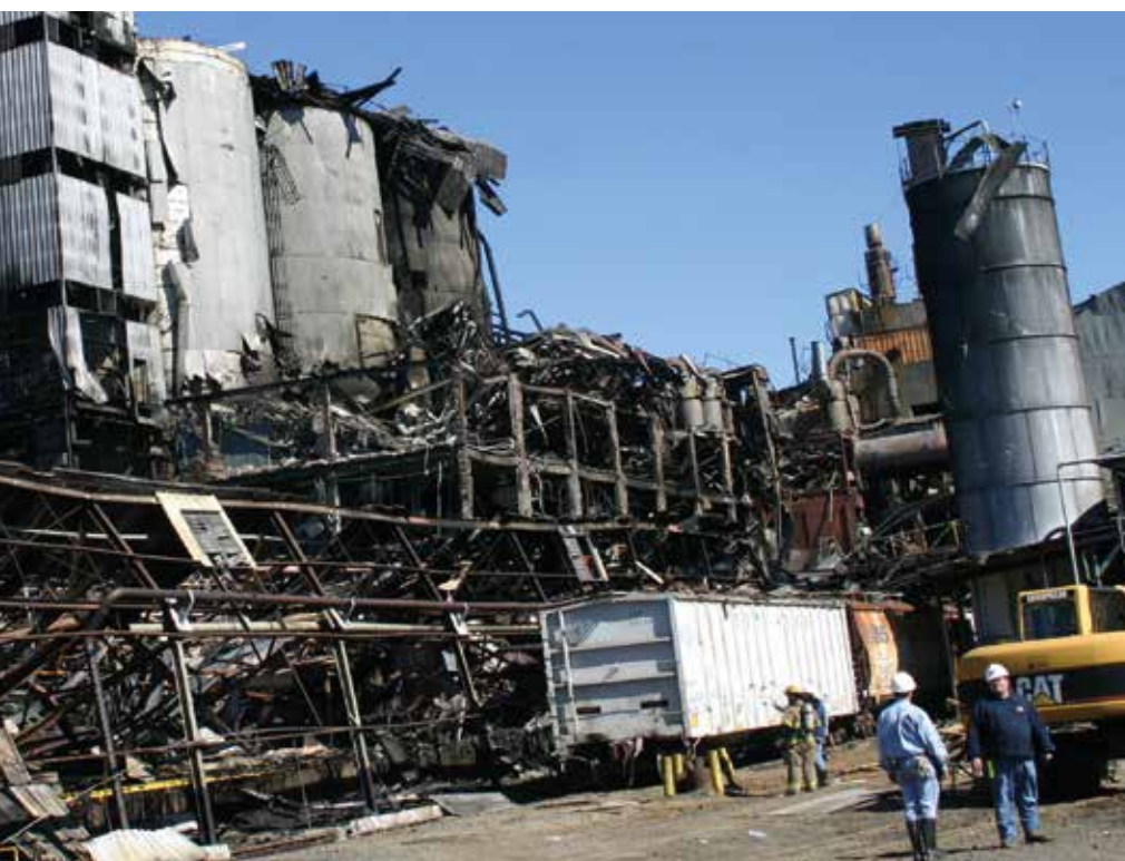
Folgen einer Staubexplosion und des ausgelösten Brandes in einer Schüttgut-Verarbeitungsanlage
