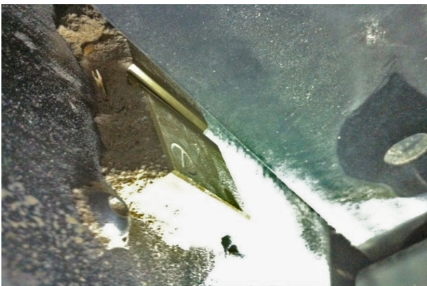
Abbildung: Verschleiß der Messingplatte eines rechteckigen Rub-Block ( Techniker vergaß, den PT100-Sensor nach der Wartung zurückzusetzen ), wobei die Messung durch den PT100-Sensor in der Luft stattfand!
