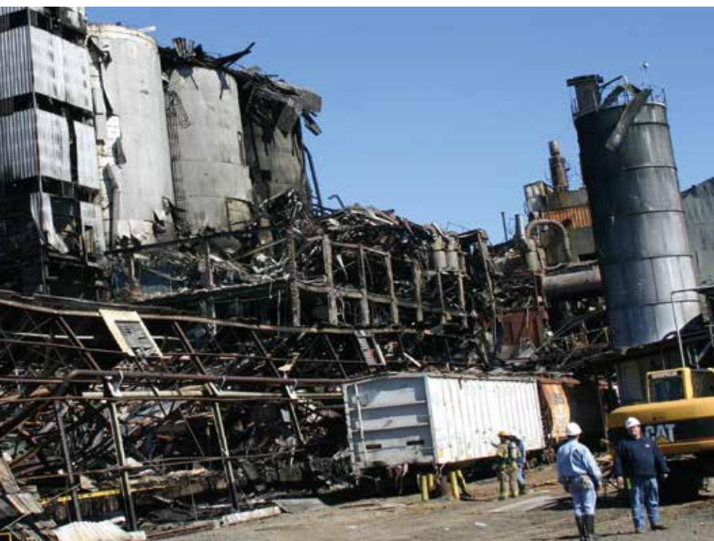
Folgen einer Staubexplosion und dadurch des ausgelösten Brandes in einer Schüttgut-Verarbeitungsanlage
