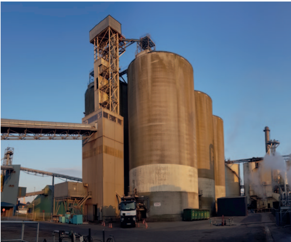
Afb. 1 De fabriek van Bunge in de haven van Brest
