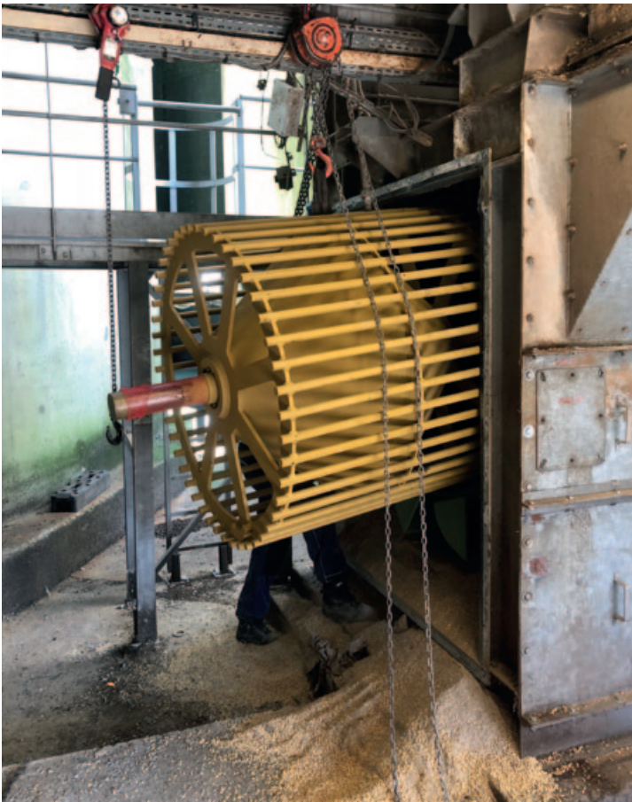
Afb. 3a en 3b De kooitrommel wordt in de installatie getakeld
