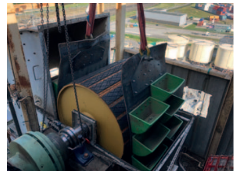
Afb. 4 De aandrijftrammel is in de kop van de elevator gemonteerd
