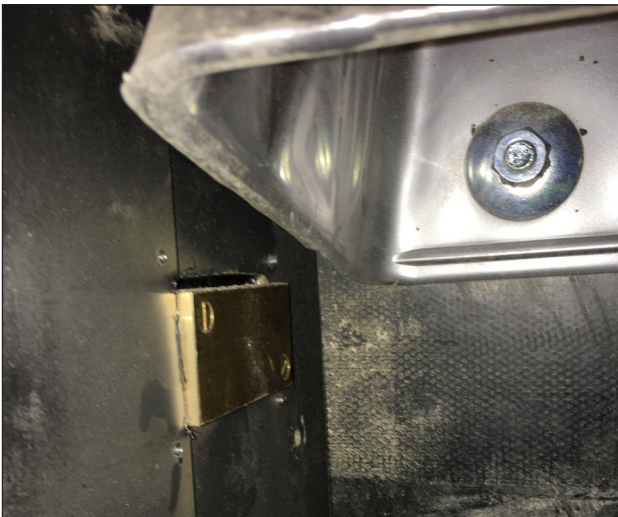
Rub-Block RB200DN gezien vanuit de binnenkant van een elevatorvoet (keertrommel en elevatorband)
