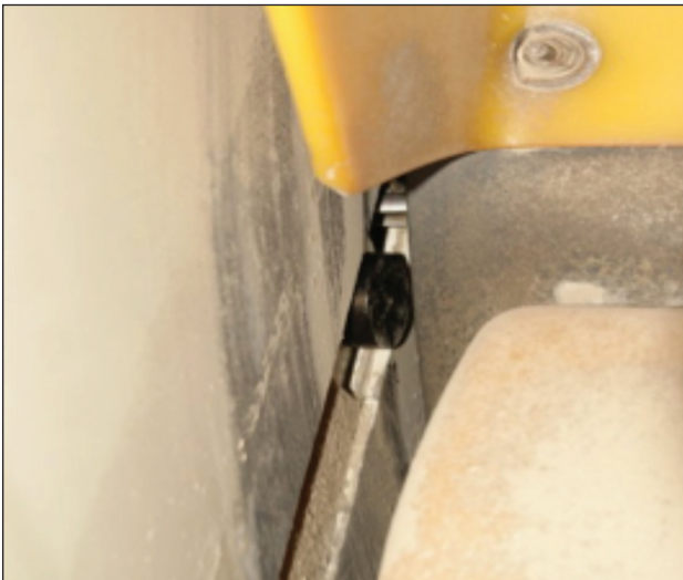
Rub-Block RB100DN gezien vanuit de binnenkant van een elevatorvoet (keertrommel en elevatorband)
